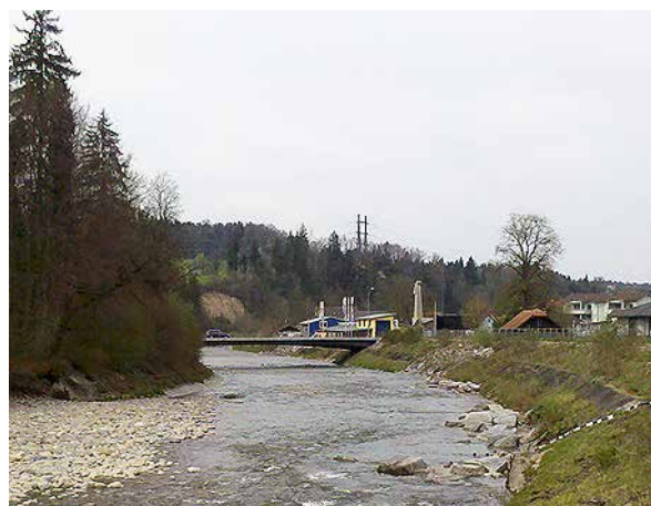
Bild 31 Blick emmenabwärts auf die Torensbergbrücke und die beidseitig gepflasterten Ufer (7.4.2014)
