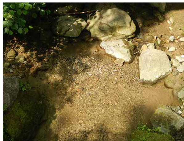
Bild 119 Ablagerungen von Feingeschiebe bachabwärts des Rückhaltebeckens (26.6.2014)
