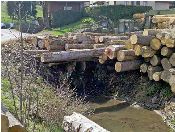
Bild 184 Ende der Eindolung und Einlauf in den Geschiebesammler (7.4.2014).
