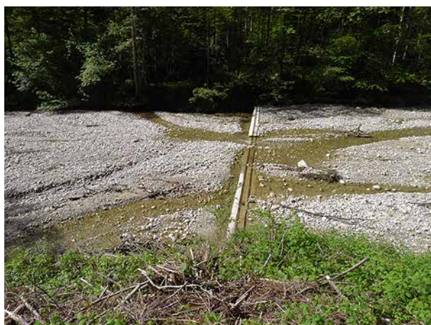
Bild 99 Einkieste Schwelle bachabwärts der Kiesentnahmestelle (6.6.2014).
