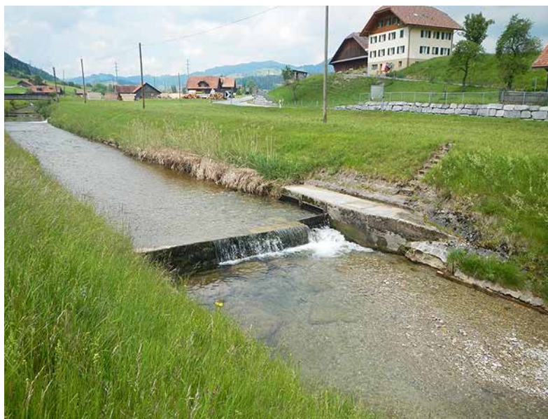
Bild 74 Wasserfassung WIE_WF3 mit seitlicher Entnahme über Einlaufrechen und kleinem Spülschütz aus Holzbrettern (3.6.2014).
