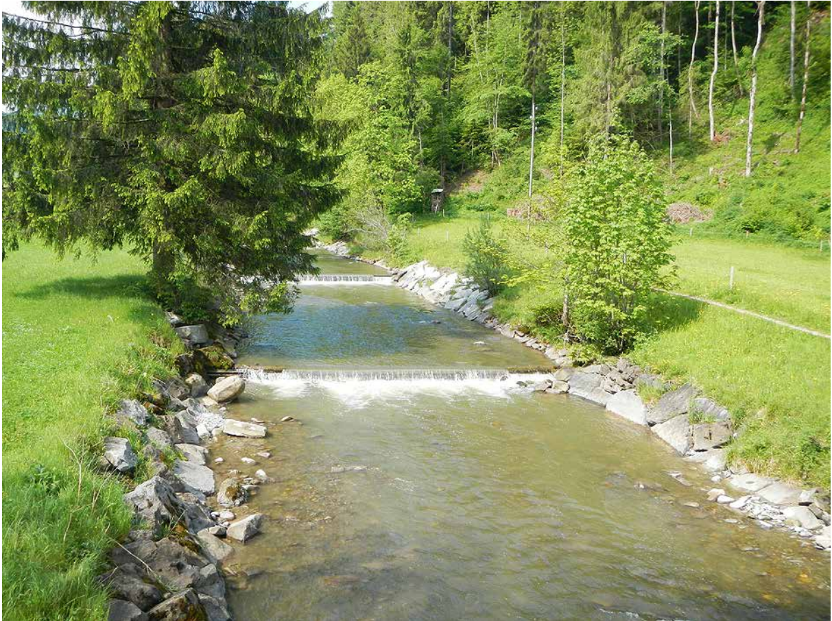
Bild 189 Stark verbautes Gerinne der Ifis flussabwärts von Marbach mit regelmässigen Schwellen und einem Uferschutz aus Blöcken. Aufgrund der starken Einengung bestehen nur sehr kleine Geschiebeablagerungen und morphologische Strukturen (03.06.2014)
