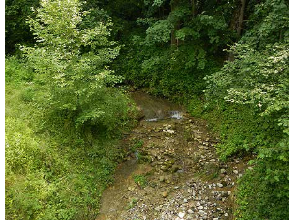
Bild 116 Felssohle und geringfügige Geschiebeablagerungen im Rückhaltebecken (26.6.2014).
