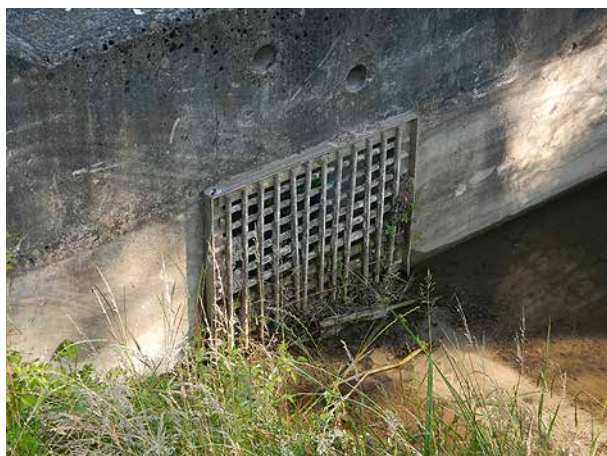
Bild 152 Feinmaschiges Gitter, welches bereits durch Gras verklaust und den Sammler einstaut (26.6.2014).
