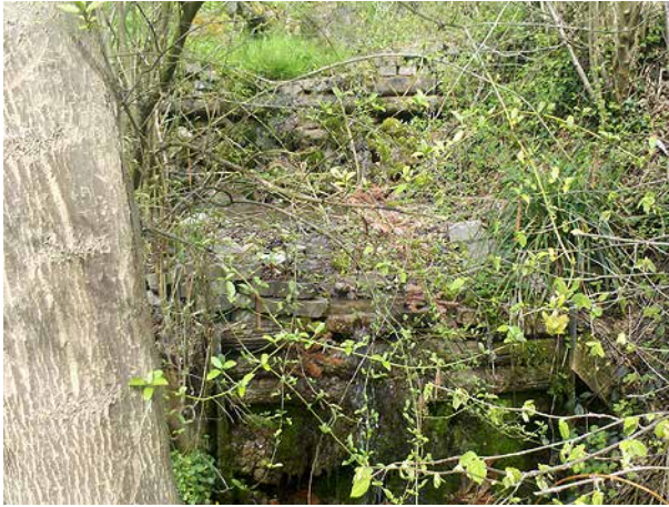
Bild 159 Stark verwachsenes und mit grossen gemauerten und mit Holz verstärkten Schwellen gesichertes Gerinne oberhalb des Sammlers (7.4.2014).
