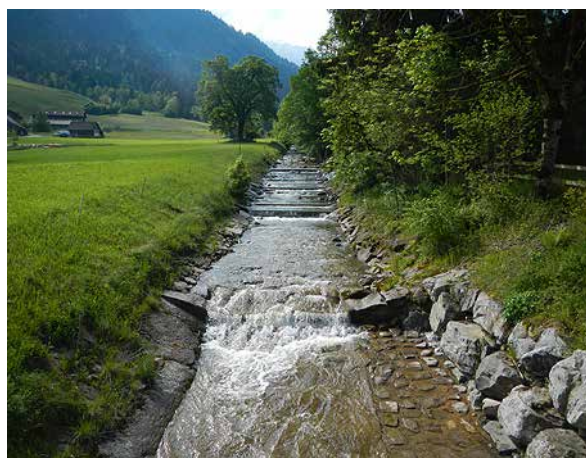
Bild 199 Stark verbautes und kanalisiertes Gerinne auf dem Schwemmkegel bachabwärts der Entnahmestelle mit Schwellen und Pflästerungen (3.6.2014)
