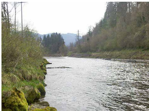
Bild 32 Blick emmenaufwärts auf die Mündung des Sagibachs (Unterwasserkanal KW Torenberg). Die Ufer sind durchgehend stark verbaut und gepflästert (7.4.2014).
