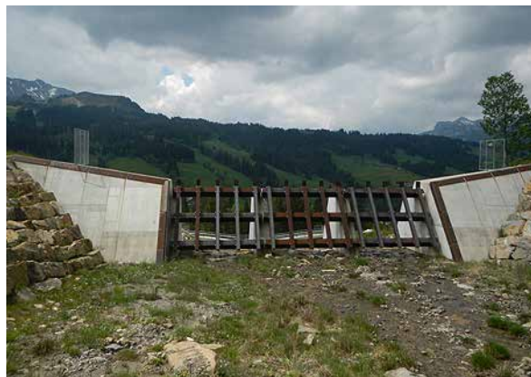
Bild 47 Geschiebesammler LAU_GSR1 mit grossem vertikalem Schwemmholzrechen (Rechenabstand 90cm, Abstand Rechen – Sohle 50cm, 3.6.2014).
