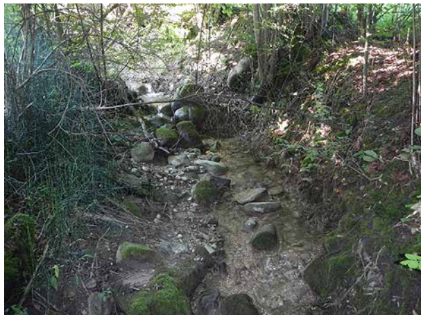
Bild 154 Enges Gerinne im Wald bachaufwärts des Sammler mit wenig Geschiebeablagerungen (26.6.2014).
