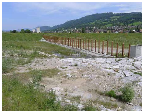
Bild 143 Neues Gerinne des Chesselbachs im Schwemmholzurückhalteraum der Kleinen Emme (KLE_SW2, 6.6.2014)
