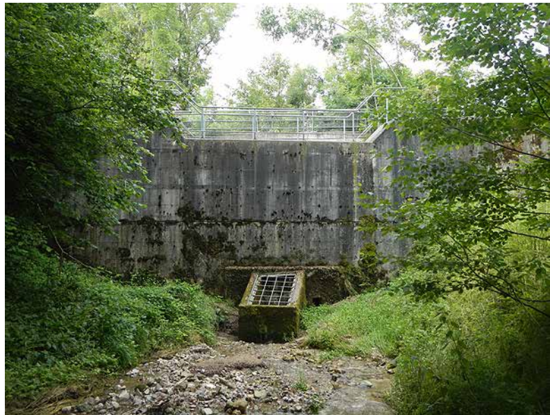
Bild 116 Felssohle und geringfügige Geschiebeablagerungen im Rückhaltebecken (26.6.2014).
