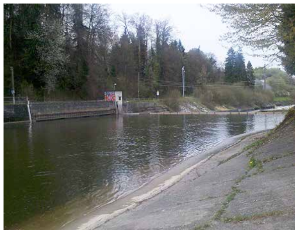
Bild 33 Blick emmenabwärts auf die Wehranlage mit seitlicher Entnahme (links) mit Geschiebeabweiser, Rechen und Geschiebeabzug (7.4.2014).
