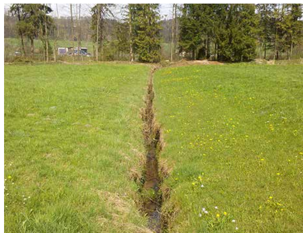
Bild 188 Mündungsstrecke kurz vor der Kleinen Emme. Das Gerinne ist eingeeengt und mit Mauern verbaut, Blick bachabwärts (7.4.2014)
