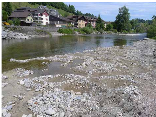
Bild 10 Ausbaggerung der Sohle an der Kurveninnenseite (6.6.2014).
