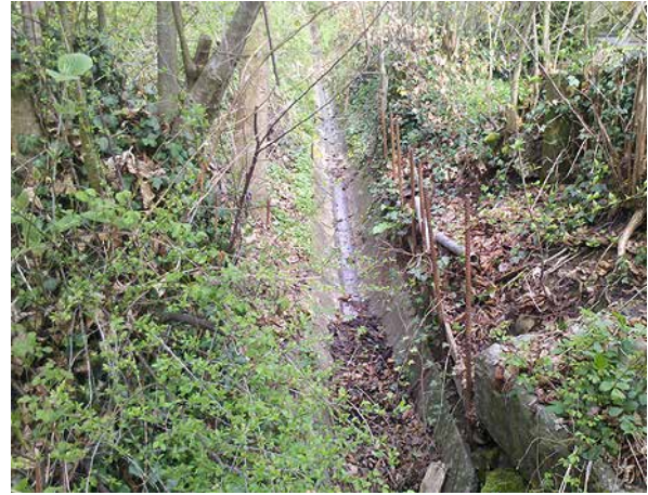
Bild 160 Oberhalb des Geschiebesammlers einmündender, in einer Betonschale verlaufender Seitenzufluss (7.4.2014).
