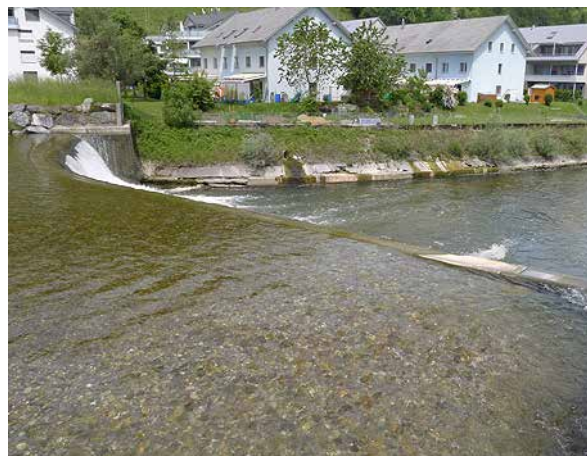
Bild 13 Blick flussabwärts auf die starre Wehrschwelle (6.6.2014).
