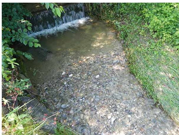
Bild 124 Feingeschiebeablagerungen im mit Holzschwellen verbauten Gerinne bachabwärts des Sammlers (26.6.2014).
