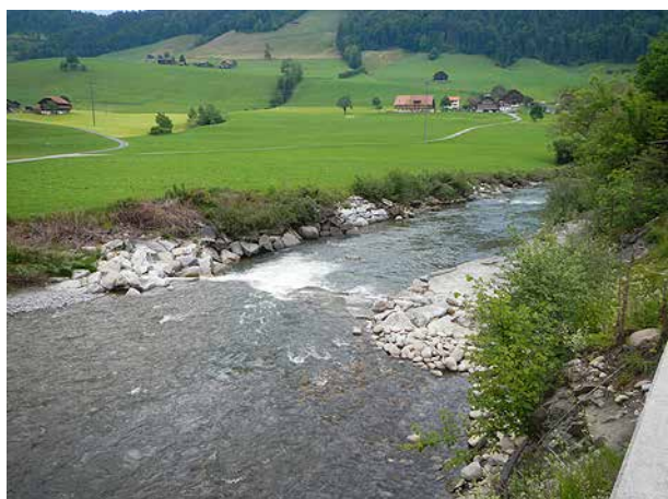
Bild 5 Künstliche Schwelle mit seitlicher, betonierter Zufahrt (rechts im Bild) flussabwärts der Holzbrücke Zingge (3.6.2014).
