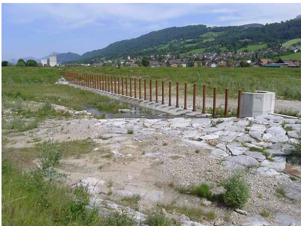
Bild 20 Grosser Holzrechen im an das Kraftwerk angegliederten Schwemmholtzrückhalteraum (6.6.2014).
