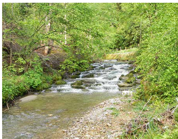
Bild 194 Mit Blockrampe und Ufermauern (Hintergrund, unterspült) verbautes Gerinne bachabwärts des Sammlers. Im Vordergrund ist eine kleine Kiesbank erkennbar (3.6.2014)
