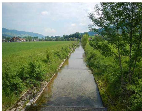
Bild 77 Kanalisierte und gleichförmige Mündungsstrecke der Wiss Emme vor der Mündung in die Waldemme (3.6.2014).
