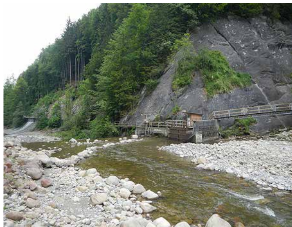
Bild 91 Blick bachabwärts auf die seitliche Wasserfassung mit Zugangssteg (3.6.2014).
