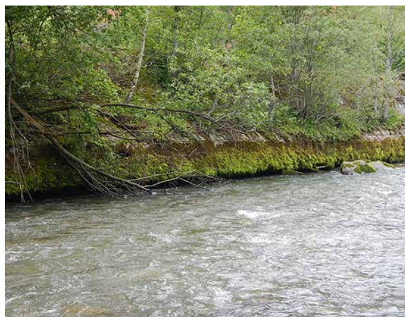
Bild 42 Unterspülte Ufermauer bachaufwärts der Entnahmestelle. Die Unterspülungen deuten auf eine Erosionstendenz und ein Geschiebedefizit (3.6.2014).
