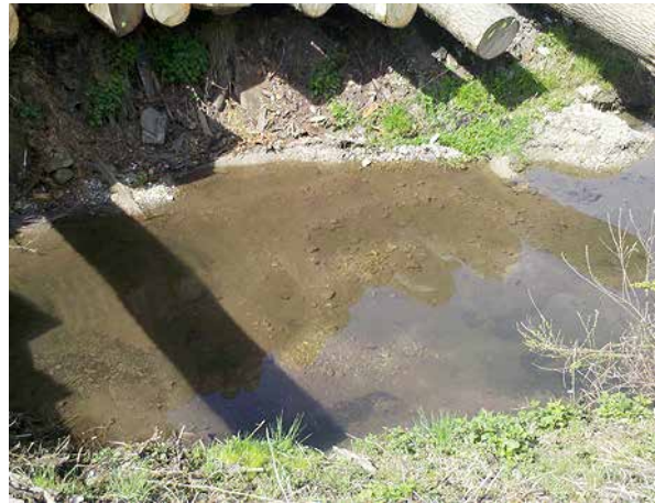
Bild 185 Kies und Feinsedimentablagerungen auf der Sohle des Sammlers. Der Sammler ist stark ausgebagert und eingestaut (7.4.2014).
