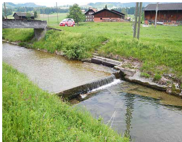
Bild 74 Wasserfassung WIE_WF3 mit seitlicher Entnahme über Einlaufrechen und kleinem Spülschütz aus Holzbrettern (3.6.2014).
