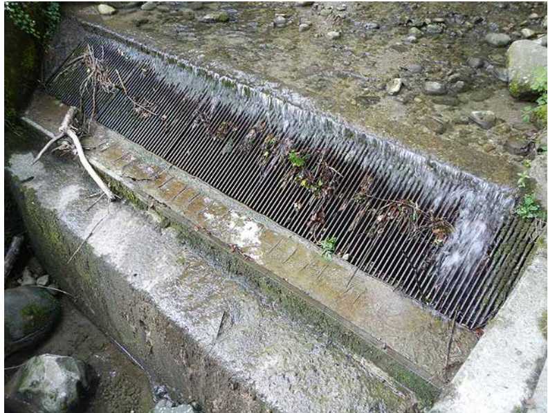
Bild 135 Feinkiesablagerungen auf grober Sohle bachaufwärts der Fassung (26.6.2014).
