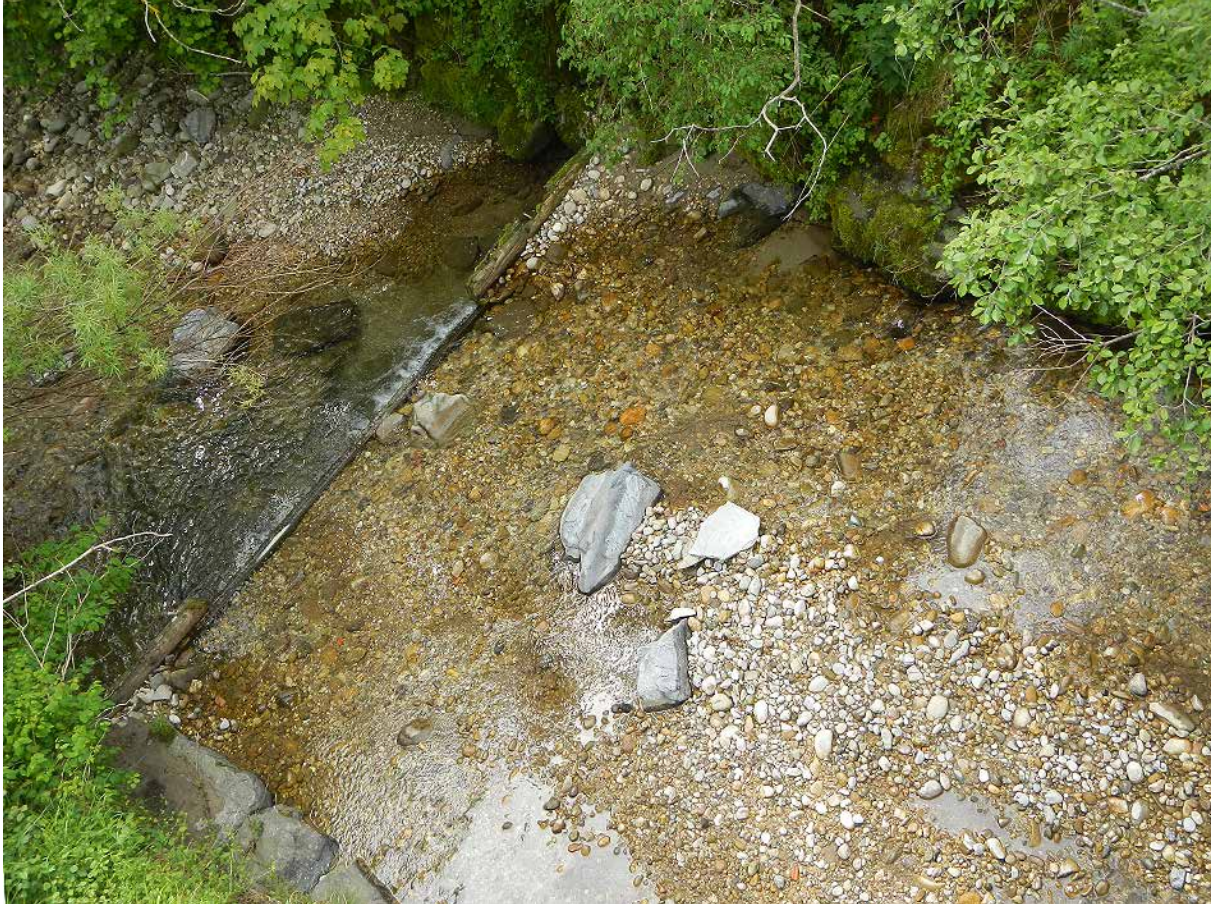
Bild 62 Stark verbautes Gerinne der Wiss Emme mit Uferschutz aus Blöcken und regelmässigen Holzschwellen. Trotz starker Einengung bestehen grossflächige Ablagerungen von Feingeschiebe auf der Sohle (03.06.2014)
