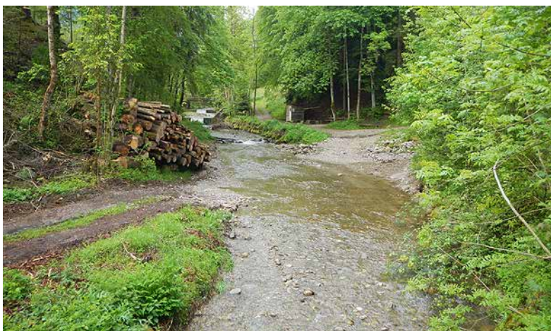
Bild 191 Mit Betonbuhnen verbautes Gerinne bachaufwärts der Entnahmestelle mit geringmächtigen Kiesablagerungen (3.6.2014).
