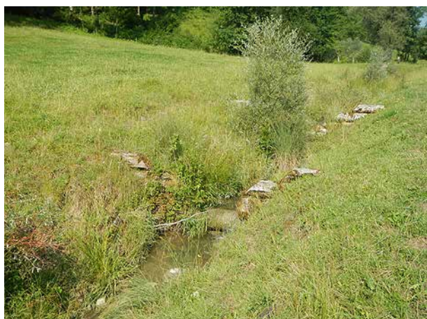
Bild 129 Begradigtes und kanalisiertes Gerinne mit regelmässigen Holzschwellen bachabwärts des Sammlers (26.6.2014).
