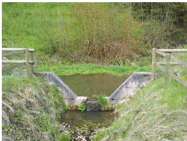
Bild 167 Blick bachaufwärts auf die Betonsperre des Geschiebesammlers (7.4.2014).
