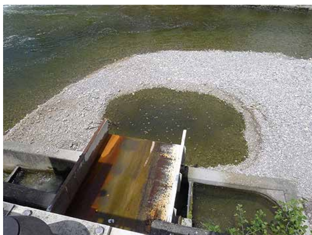
Bild 15 Auslauf der Spülrinne zur Spülung des Oberwasserkanals (6.6.2014).
