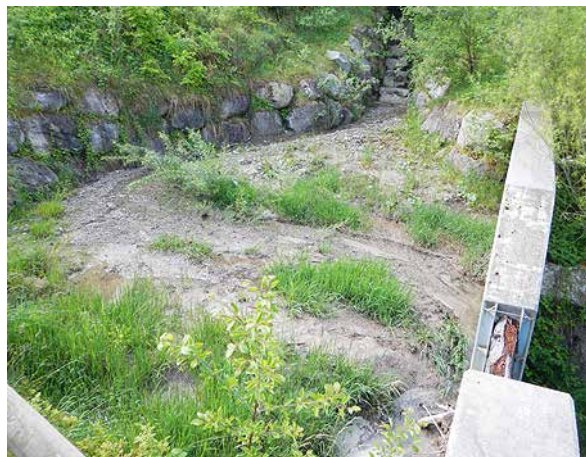
Bild 201 Geschiebesammler mit Blockrampe als Einlauf (oben im Bild) und mächtigen, teilweise bewachsenen Feinsedimentablagerungen (3.6.2014).
