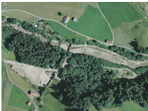
Bild 60 Luftbild der oberen Entnahmestelle ROB_KS1 (oberhalb der Schwellen, Fliessrichtung rechts nach links) und des Aufbereitungs- und Lagerplatzes (Quelle: map.geo.admin.ch, 3.6.2014).
