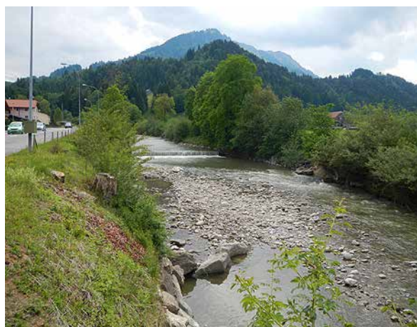
Bild 45 Stark beeinträchtigt, mit Blöcken und einzelnen Schwellen verbautes Gerinne bachabwärts der Entnahmestelle (3.6.2014)
