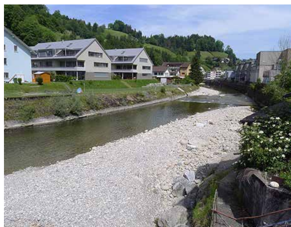
Bild 16 Geschiebeablagerungen in der Restwasserstrecke unterhalb der Wehrschwelle. Die Ufer sind stark verbaut und es bestehen regelmässige Schwellen (6.6.2014)
