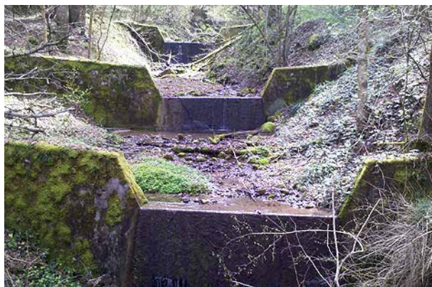
Bild 169 Wildbachsperren in der Tobelstrecke oberhalb des Siedlungsgebietes (7.4.2014).
