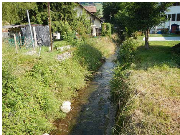
Bild 142 Gepflästerte Bachschale zwischen Geschiebesammler und Hauptstrasse (26.6.2014).
