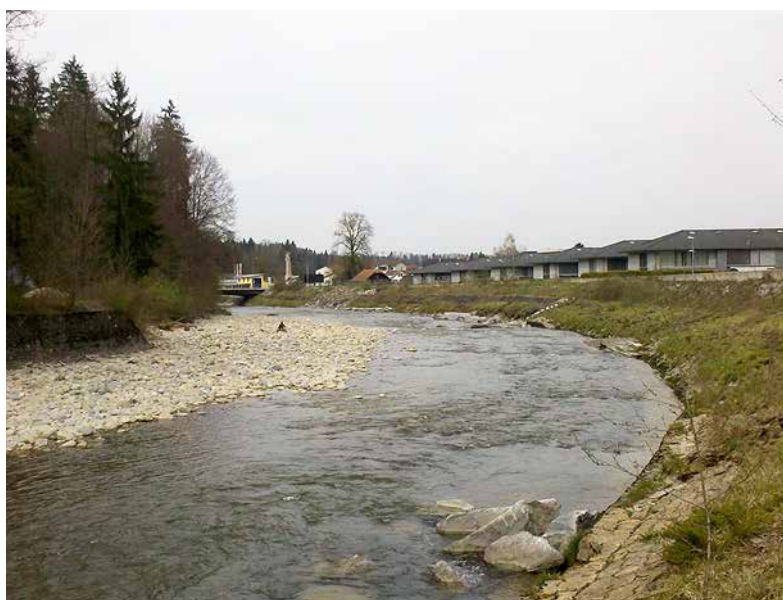
Bild 29 Blick emmenabwärts auf die Torensbergkurve mit Kiesbank und Ufermauern an der Kurveninnenseite, sowie gepflasterter Kurvenaußenseite (7.4.2014).
