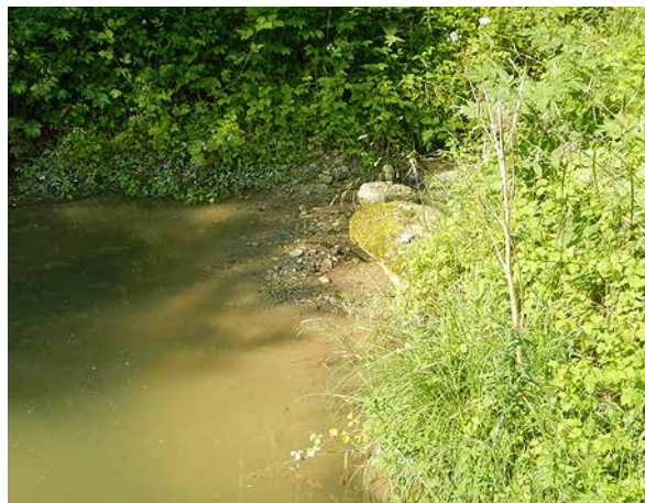
Bild 127 Kleine Geschiebeablagerungen am Einlauf des Sammlers (26.6.2014).
