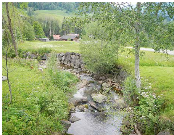
Bild 56 Mit Blöcken verbaute Mündungstrecke im Gebiet des Golfplatzes Flüfli (3.6.2014)
