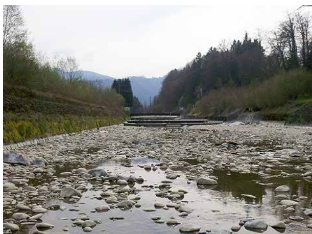
Bild 35 Restwasserstrecke und Wehranlage emmenaufwärts betrachtet (7.4.2014).
