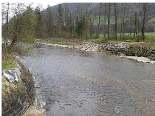
Bild 25 Blick in die Restwasserstecke unterhalb des Wehres (7.4.2014).
