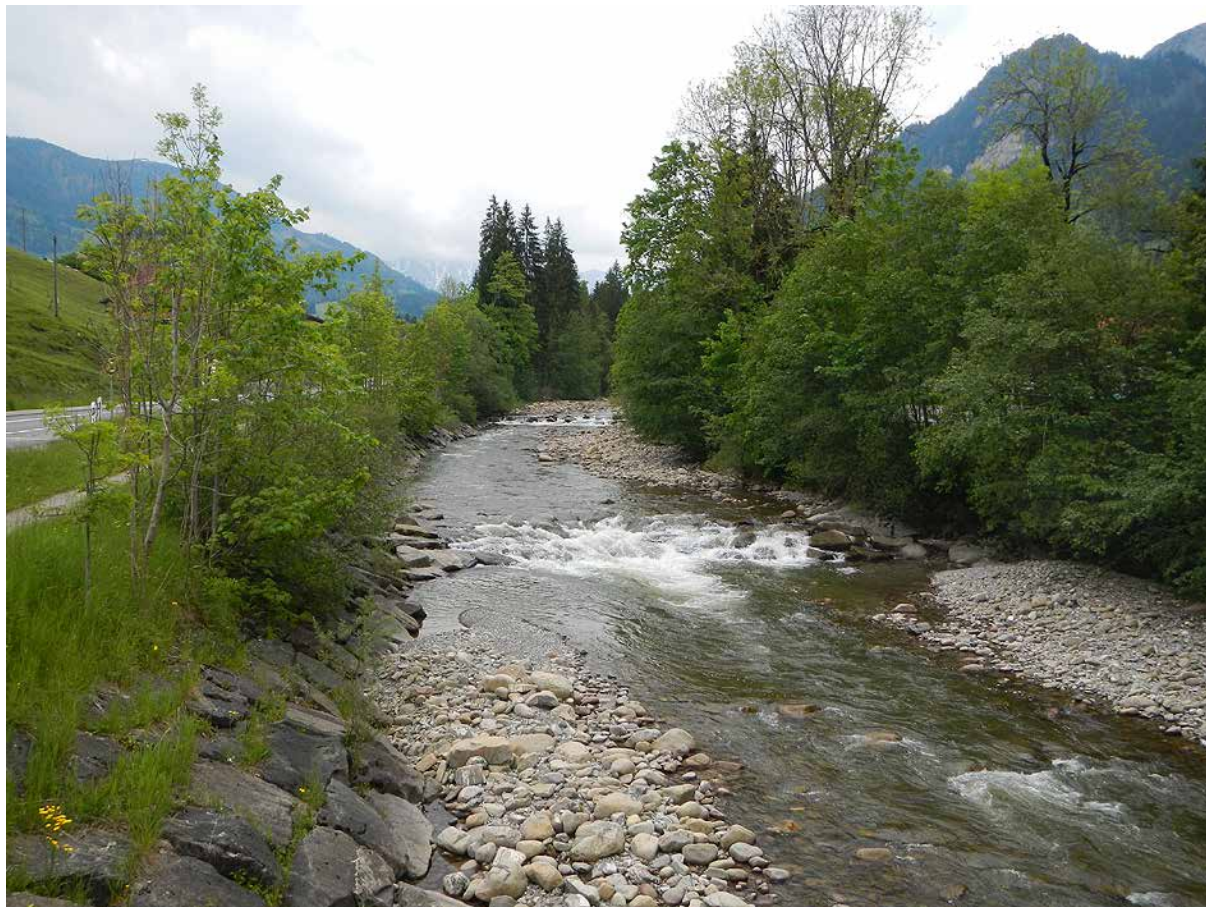
Bild 40 Waldemme flussaufwärts von Flühli mit Uferschutz aus Blöcken und regelmässigen Blockschwellen. Trotz des kanalisierten Gerinnes bestehen regelmässig Kiesbänke. Diese bestehen jedoch mehrheitlich aus grobem Material und weisen geringe Anteile an Feingeschiebe auf (03.06.2014)
