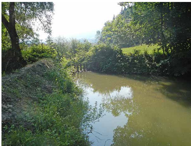
Bild 128 Blick in den Geschiebesammler mit Dammschüttung (links) und Schwemmholzrechen. Das Becken ist eingestaut und hält alles Geschiebe zurück (26.6.2014).
