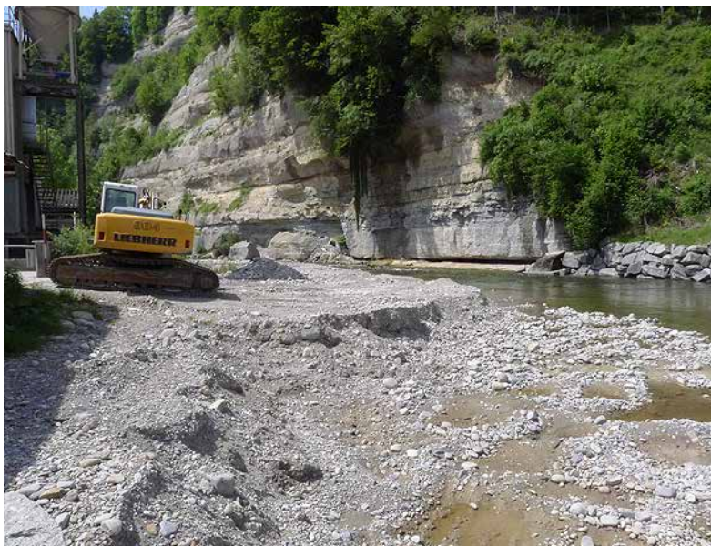
Bild 8 Wenig beeinträchtigt es Gerinne mit Kiesbank aus Feingeschiebe flussaufwärts der Kiesentnahmestelle (6.6.2014).
