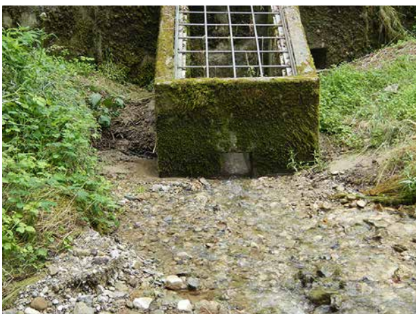
Bild 118 Drosselbauwerk mit verschieden hoch angeordneten, quadratischen Öffnungen (30 x 30cm) und Einlaufgitter (26.6.2014).
