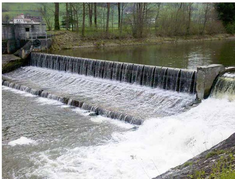
Bild 23 Blick emmenabwärts auf die seitliche Wasserentnahme (links) mit Geschiebeabweiser, Schwemmholzrechen und Geschiebeabzug (7.4.2014).
