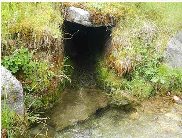
Bild 66 Einlauf der Hochwasserentlastung in die Wiss Emme (3.6.2014).
