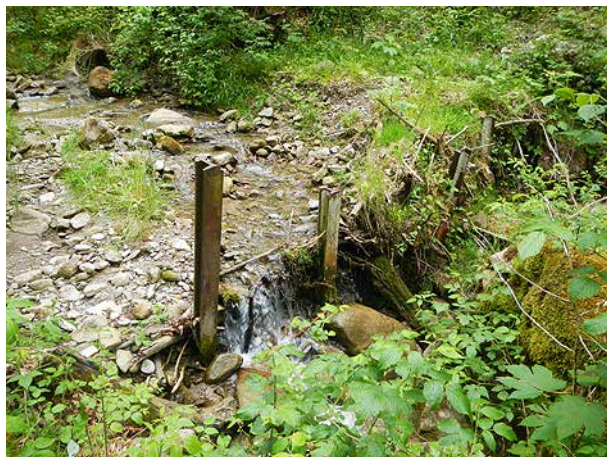
Bild 79 Alter Schwemmholzrechen aus vertikalen Eisenbahnschienen bachaufwärts des Sammlers, hinterfüllt und teilweise beschädigt (3.6.2014).
