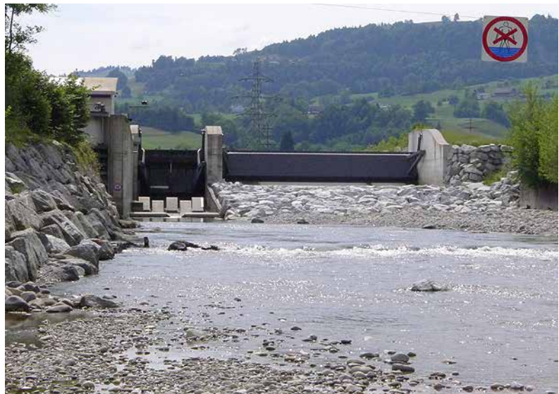
Bild 18 Blick flussabwärts auf Wehranlage und Kraftwerk (links) und Überlauf in den Schwemmholtzrückhalt (rechts). In der Mitte des Gerinnes besteht eine Insel (6.6.2014).
