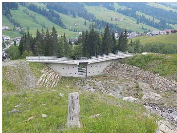
Bild 48 Blick in den Geschiebesammler LAU_GSR2 mit horizontalem Stahlrechen (Rechenabstand 40cm, 3.6.2014).
