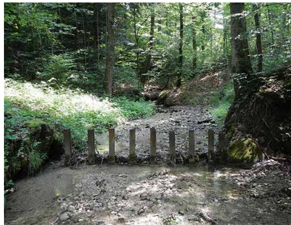
Bild 111 Kleiner, leicht verkleuster Schwemmholzrechen bachaufwärts des Rückhaltebeckens (26.6.2014).
