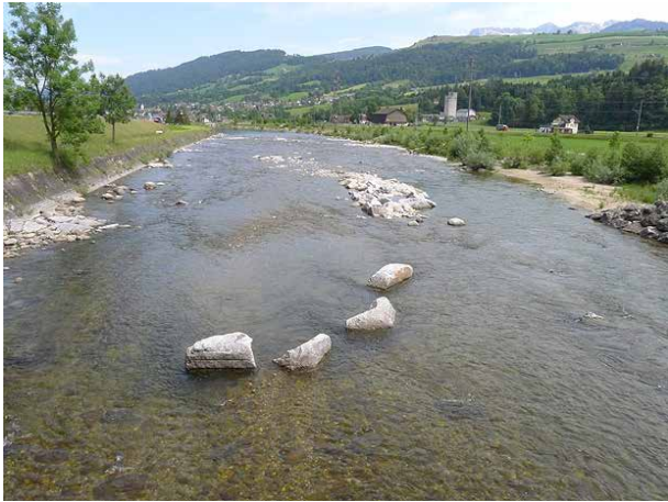
Bild 17 Kleine Aufweitung (rechtsseitig) mit kleinen Kiesbänken und Belebungsblöcken flussaufwärts des Kraftwerks (Blick flussabwärts, 6.6.2014).
