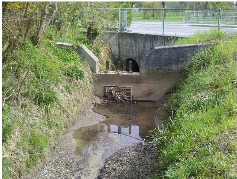
Bild 160 Oberhalb des Geschiebesammlers einmündender, in einer Betonschale verlaufender Seitenzufluss (7.4.2014).
