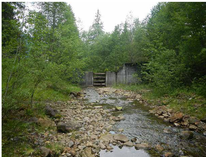
Bild 53 Überwachener Uferverbau aus Blöcken bachaufwärts des Sammlers (3.6.2014).
