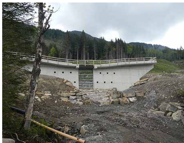
Bild 49 Baugleicher Geschiebesammler LAU_GSR3 mit horizontalem Schwemmholzrechen, noch nicht fertiggestellt (3.6.2014).
