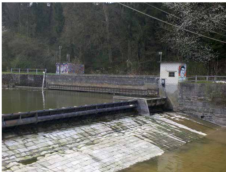
Bild 33 Blick emmenabwärts auf die Wehranlage mit seitlicher Entnahme (links) mit Geschiebeabweiser, Rechen und Geschiebeabzug (7.4.2014).
