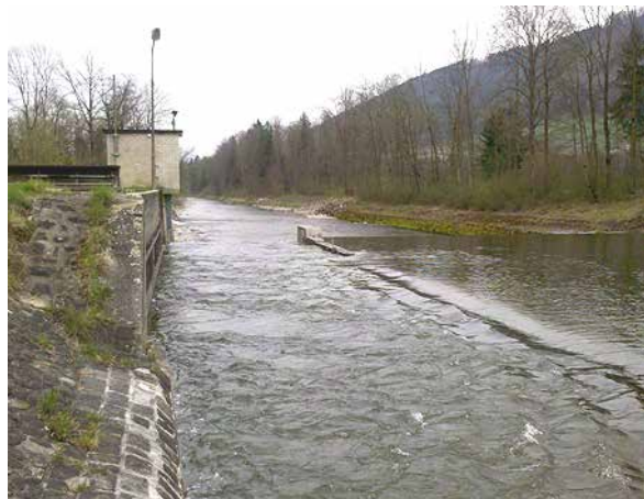
Bild 23 Blick emmenabwärts auf die seitliche Wasserentnahme (links) mit Geschiebeabweiser, Schwemmholzrechen und Geschiebeabzug (7.4.2014).
