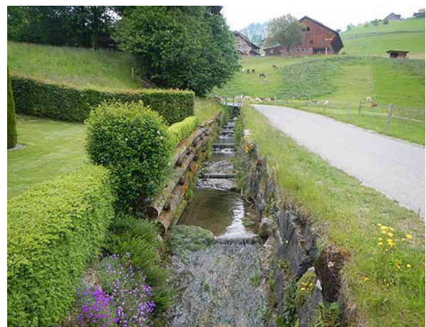
Bild 88 Stark beeinträchtigt Gerinne bachabwärts des Sammlers mit Ufer- und Sohlenverbau aus Holz und im Bach entsorgtem Rasenschnitt (3.6.2014)
