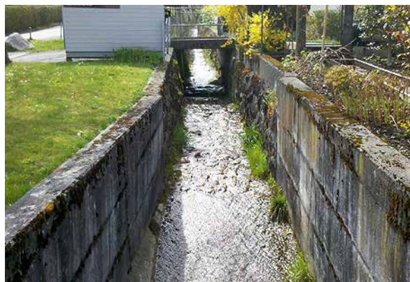
Bild 170 Steile, gepflästerte und stark verbaute Bachschale im Siedlungsgebiet oberhalb der Hauptstrasse (7.4.2014).
