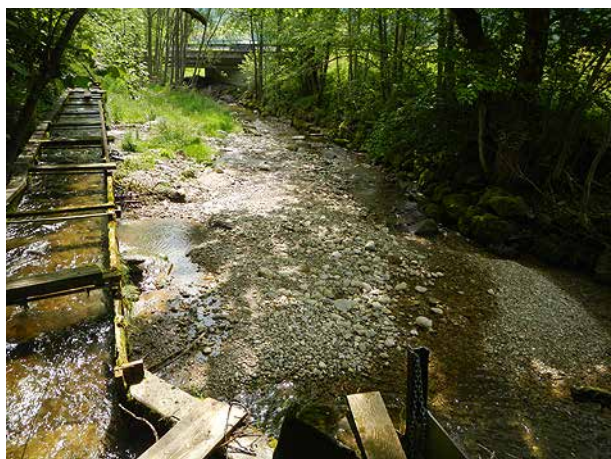
Bild 71 Blick bachabwärts auf den Holzkanal und die Geschiebeablagerungen in der Restwasserstrecke (3.6.2014).
