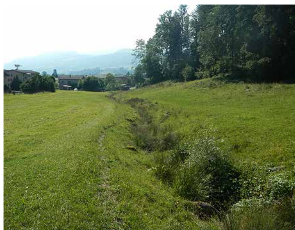
Bild 130 Blick vom Geschiebesammler bachabwärts Richtung Schachen (26.6.2014)
