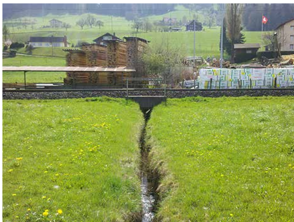
Bild 187 Blick bachaufwärts auf die Eindolung unter der Hauptstrasse und der Eisenbahn. Das Gerinne verläuft anschliessend kanalisiert und stark verbaut (7.4.2014).
