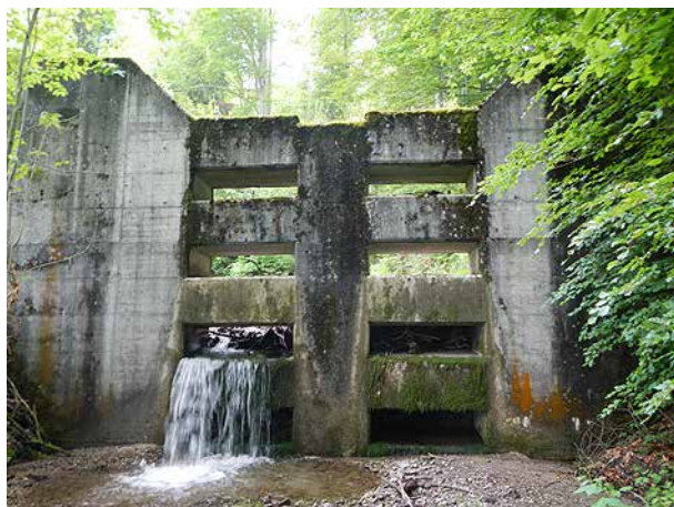
Bild 82 Blick bachaufwärts auf die Betonsperre des Sammlers, die unterste Lochreihe ist komplett verkleust und hinterfüllt (3.6.2014).
