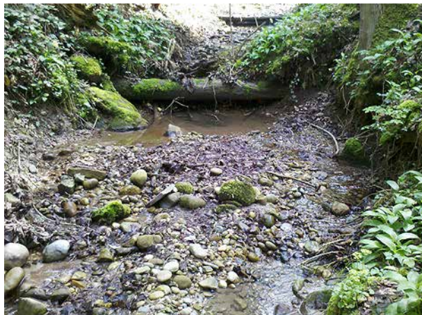
Bild 179 Naturnahes Gerinne mit Kiesbänken und einzelnen kleinen Holzschwellen im Tobelabschnitt oberhalb des Sammlers (7.4.2014).
