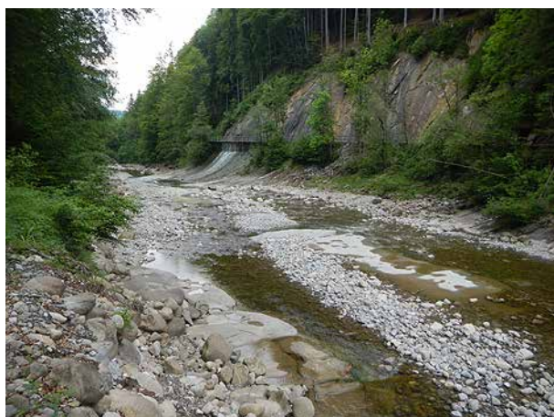
Bild 93 Auf Felssohle verlaufendes Gerinne bachabwärts der Wasserfassung mit seitlich dem Fels entlang geführtem Ausleitkanal (3.6.2014).
