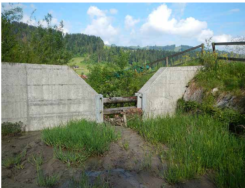
Bild 201 Geschiebesammler mit Blockrampe als Einlauf (oben im Bild) und mächtigen, teilweise bewachsenen Feinsedimentablagerungen (3.6.2014).
