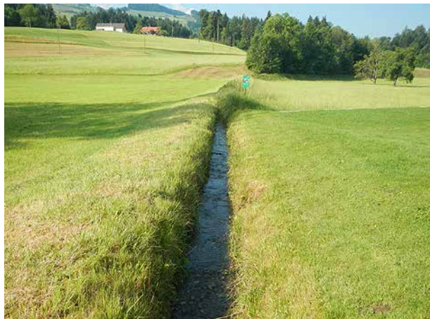
Bild 144 Erhöht zwischen Dämmen verlaufendes Gerinne des linken Zuflusses (26.6.2014).
