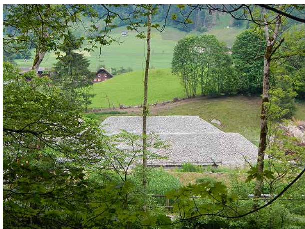
Bild 44 Geschiebedepots neben der Entnahmestelle mit einem geschätzten Volumen von 1'000 – 2'000m 3 (3.6.2014).
