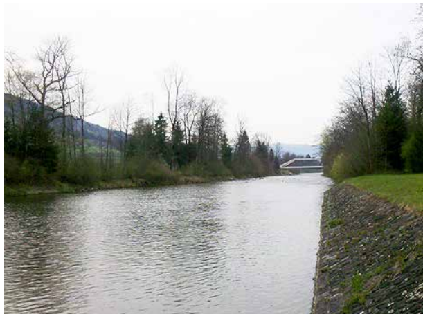
Bild 22 Blick emmenaufwärts auf den Stauraum des Wehrs Torenberg. Die Ufer im Wehrbereich sind gepflästert (7.4.2014).
