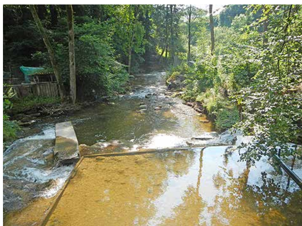
Bild 108 Blick bachabwärts auf die Schwelle mit Schusrinne (links) und Fassung (rechts, 26.6.2014).
