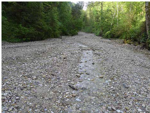
Bild 96 Blick bachaufwärts auf die Kiesentnahmestelle im Gerinne der kleinen Fontanne (6.6.2014).
