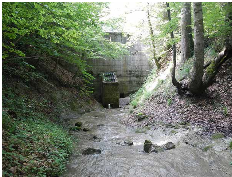
Bild 111 Kleiner, leicht verkleuster Schwemmholzrechen bachaufwärts des Rückhaltebeckens (26.6.2014).
