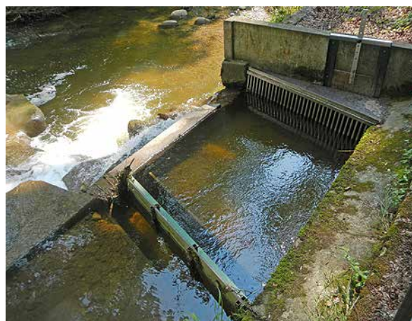
Bild 109 Tauchwand und Einlaufrechen der Wasserfassung (26.6.2014)
