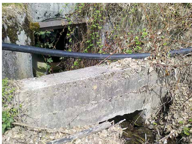
Bild 177 Betonsperre mit Rechtecköffnung, sowie Einlauf in die Eindolung unter der Strasse gerade unterhalb des Sammlers, Blick bachabwärts (7.4.2014).
