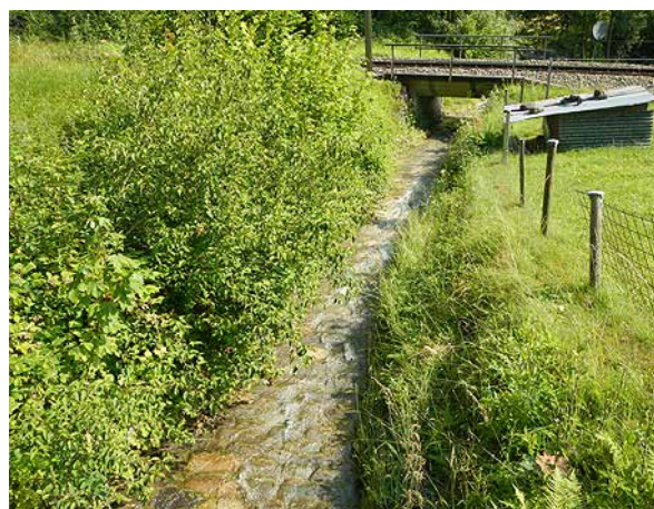
Bild 125 Gepflasterter Mündungsbereich mit Unterquerung der SBB Linie (26.6.2014)
