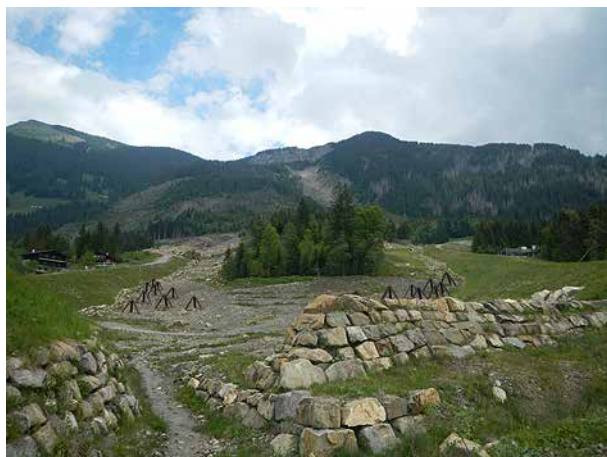
Bild 50 Grosse Aufweitung mit Dammschüttungen und Murgangbremsen ohne Auslaufbauwerk (LAU_GS4, 3.6.2014).
