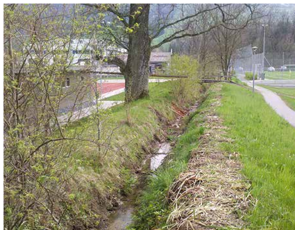
Bild 168 Begradigtes und erhöht zwischen Dämmen verlaufendes Gerinne im Bereich der Sportanlage Ei unterhalb des Sammlers (7.4.2014)
